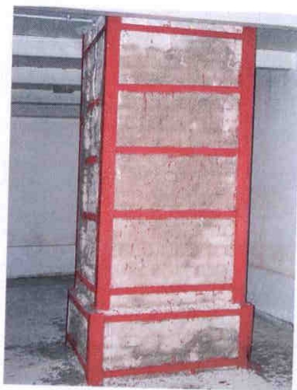
Obrázek 4.92 Ocelová bandáž sloupu
